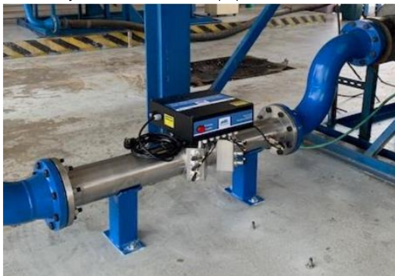
Detalhe do sensor desenvolvido e do equipamento em funcionamento em uma das baias da Usina de Maracanaú
